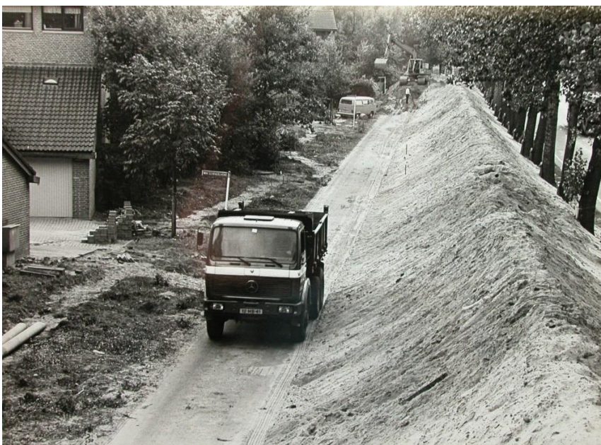
Aanleg van de geluidswal
