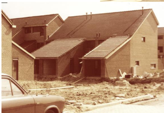
Bouw van de woningen
