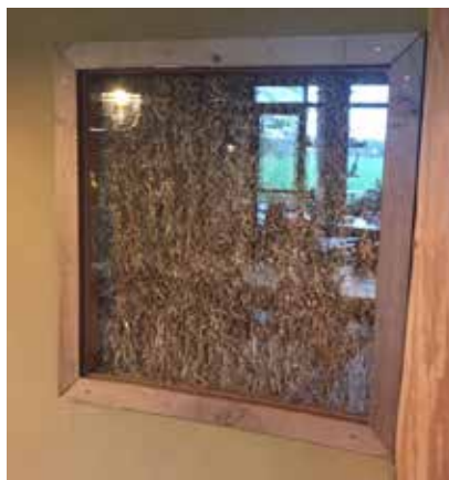
Truth window met muren van stro, afgewerkt met leem in het Biotel in Lieveelde
